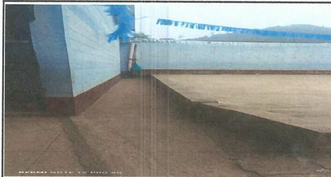
Foto 2: Mejoramiento de canal con rejilla de metal en el area del patio
