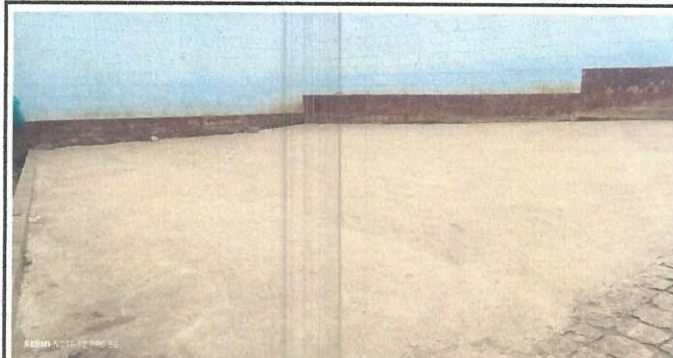
Foto 2: Mejoramiento con portico estructural de techo con lamina troquelada en el area del patio.
