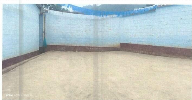
Foto1: Mejoramiento con portico estructural de techo con lamina troquelada en el area del patio.
